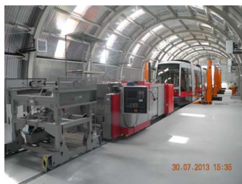
Interior hală Mecatronică
