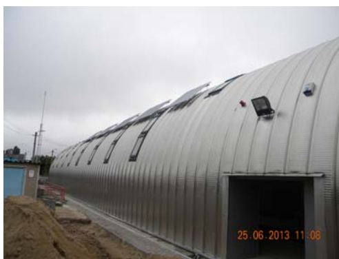
Exterior hală Mecatronică
